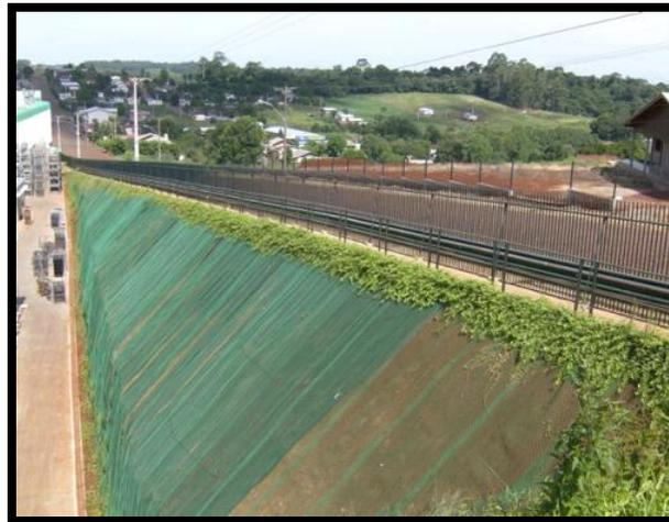
**Figura 05:** Telas de proteção para sustentação de taludes.
