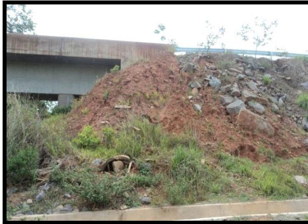
**Figura 11:** Taludes sem cobertura de gramíneas.
